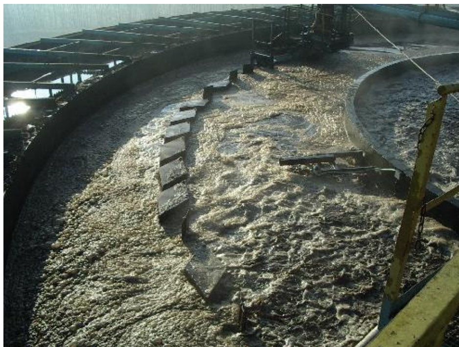
Rys. 3 Powierzchnia komory biostabilizacji w dniu 5 maja 2003 r. z widoczną warstwą lekkiej piany technologicznej
